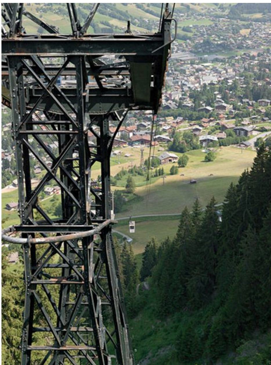
Détail d'un pylône depuis l'amont
