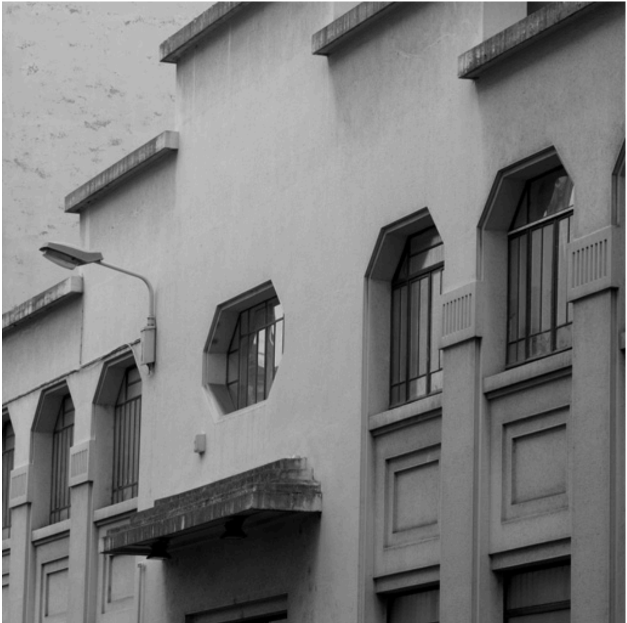
Détail verrières, vue nord
