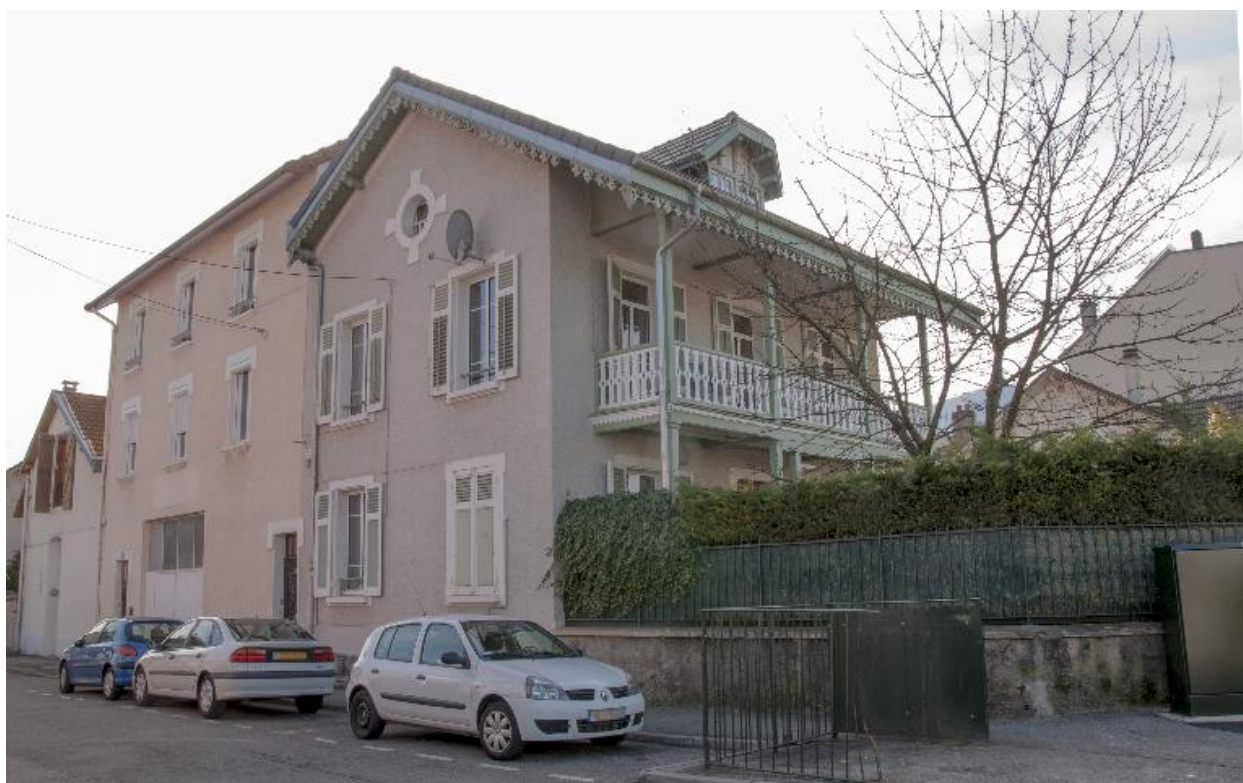
Pignon nord et façade est
