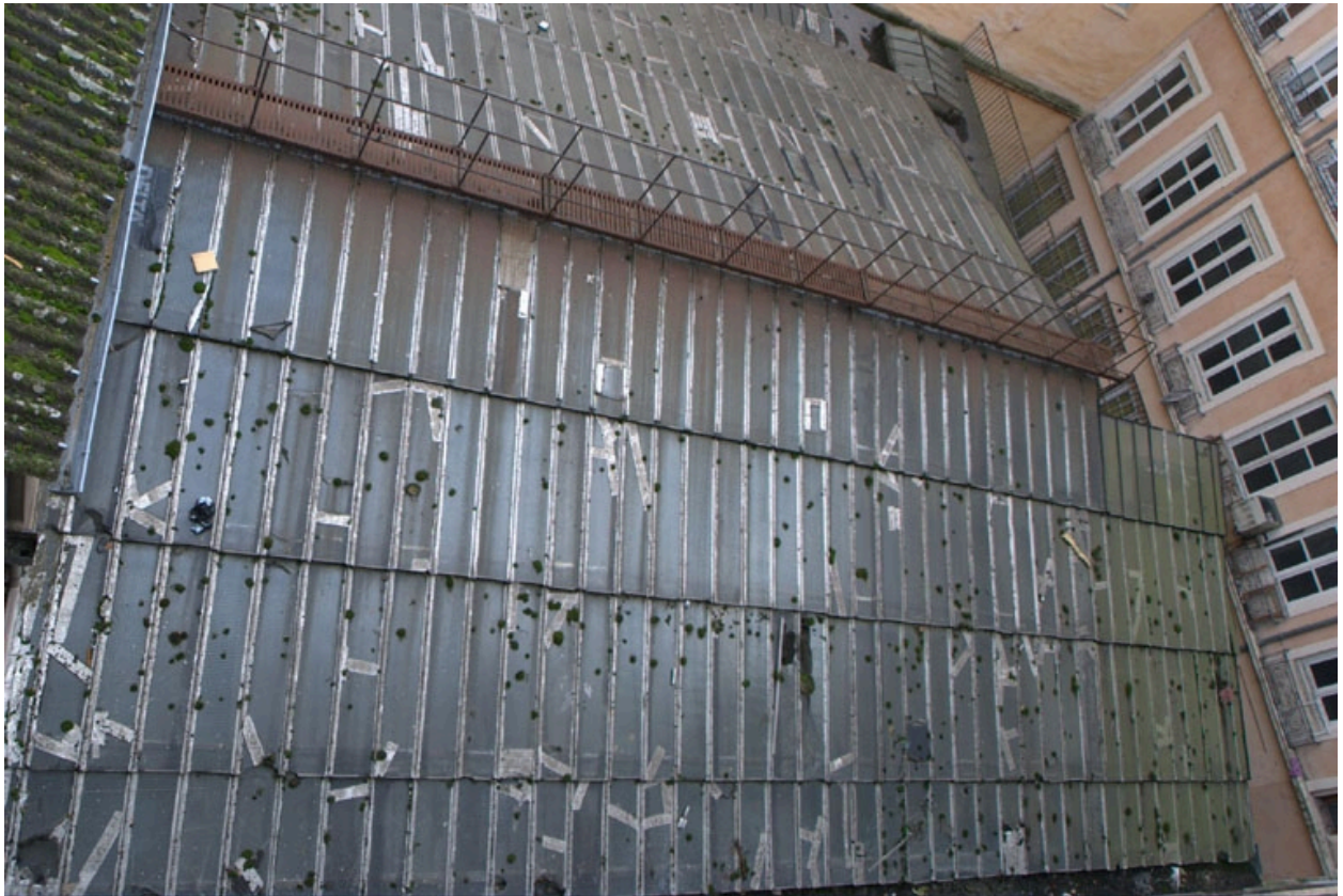
Détail passerelle de la verrière
