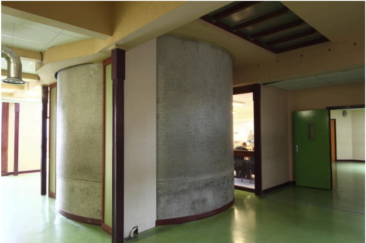
Bâtiment A, 1er étage. Cloisonnement autour d'une cuve. Derrière la vitre, une salle de cours.
