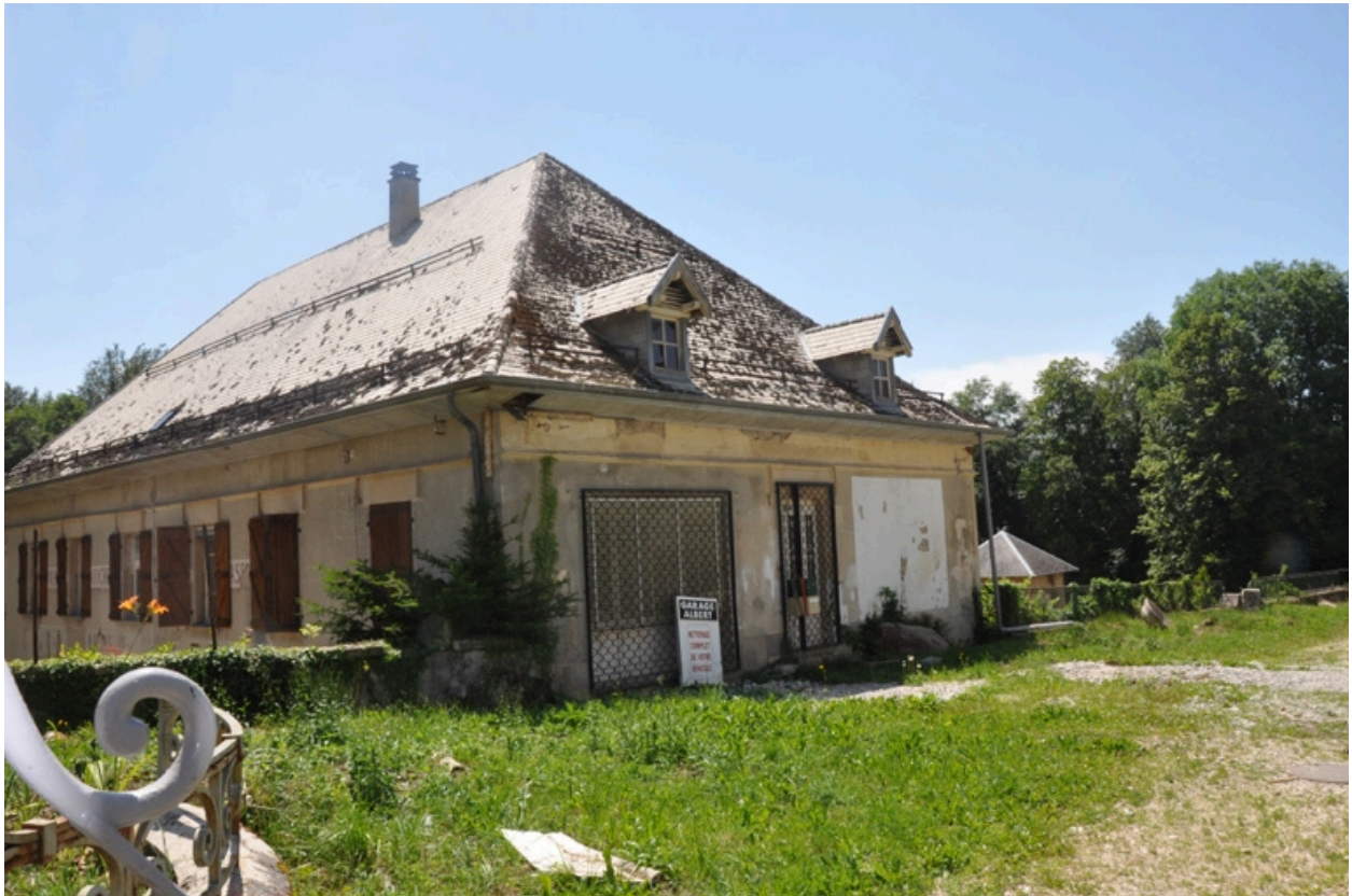
Vue de la façade nord du bâtiment des soins
