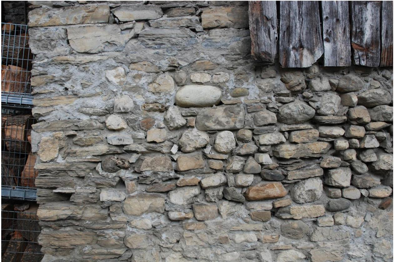
Détail de matériau : maçonnerie de moellons lité et galets (2018 D2 1782).
