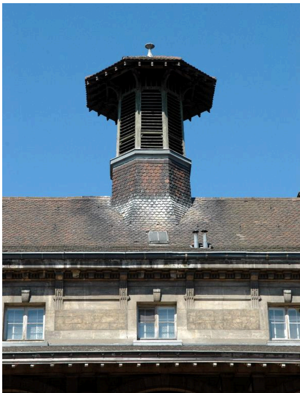
Cour d'honneur, bâtiment principal, campanile
