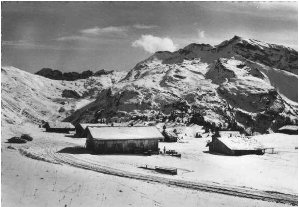
Ouverture de la route jusqu'aux chalets d'alpage, hiver 1950. Photogr.
