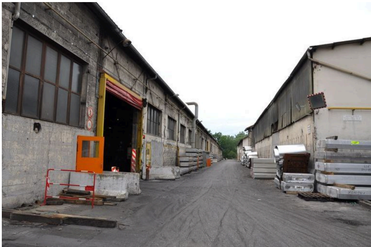
Mur goutterau de la halle de la fonderie
