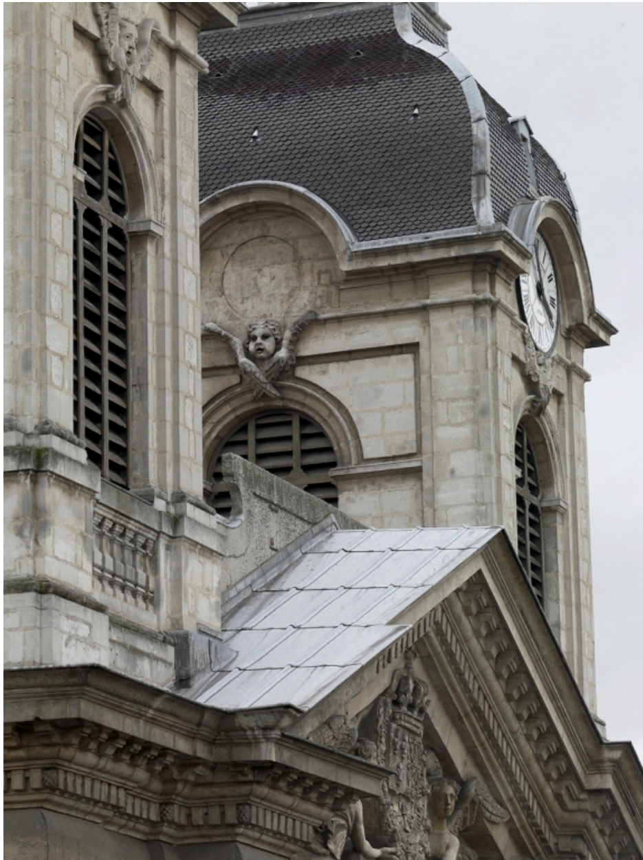
Détail du clocher sud, depuis le nord
