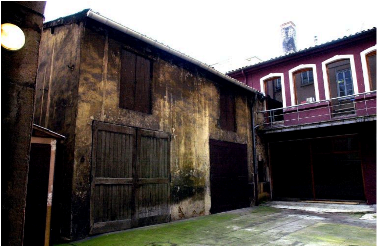
Vue des remises à gauche de la cour
