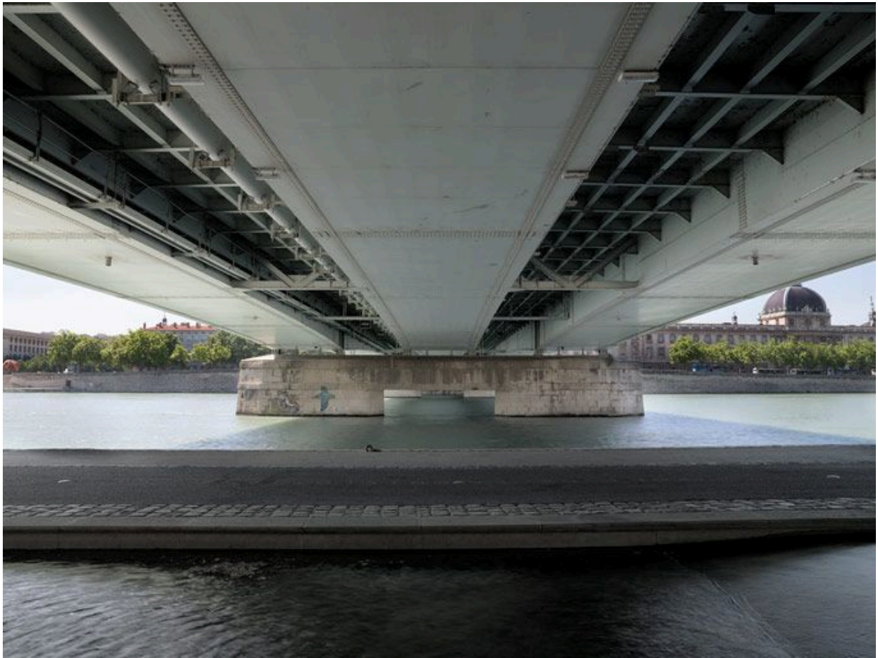
La double pile du pont côté rive gauche depuis le quai bas
