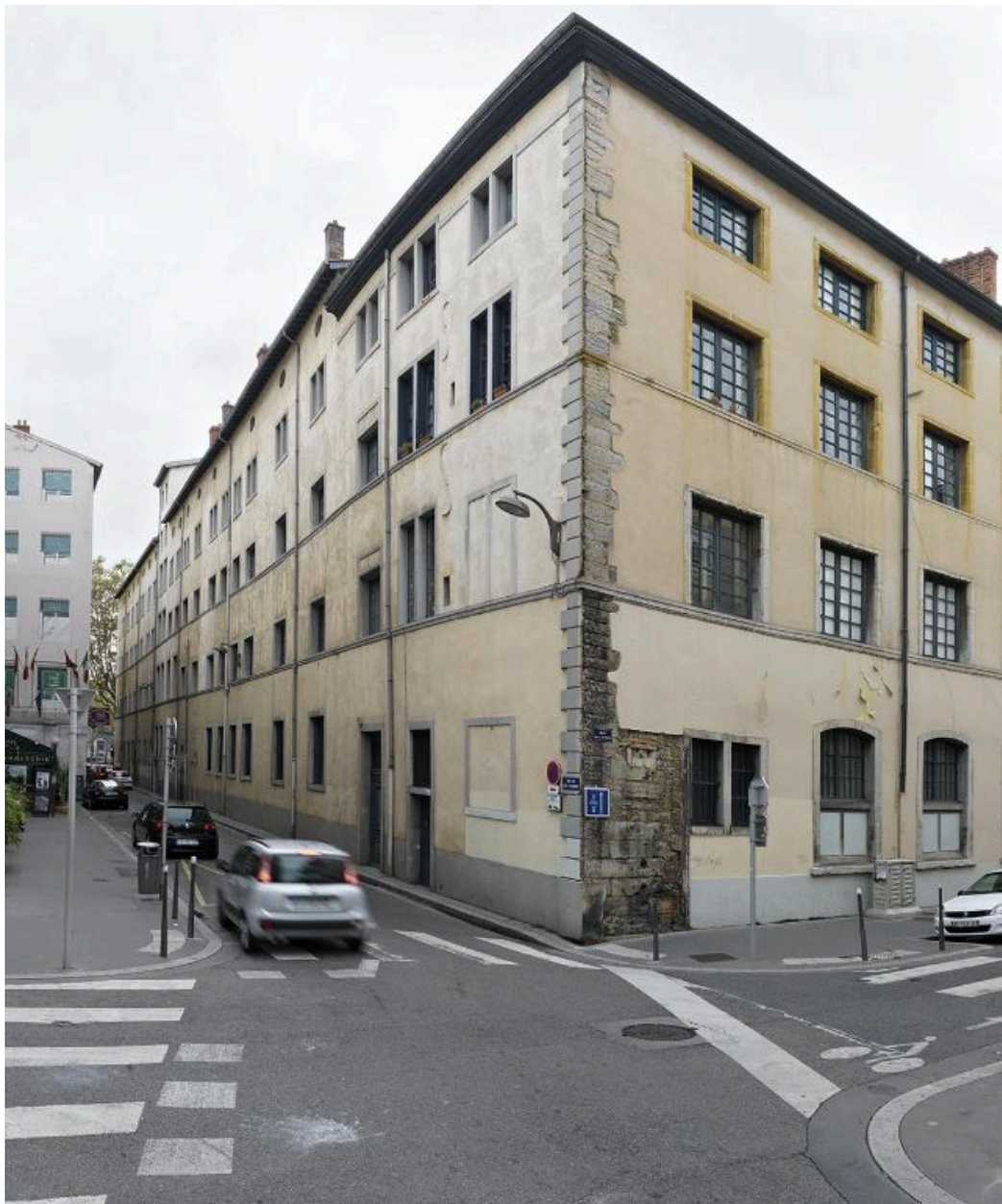
Elévation latérale nord, vue d'ensemble depuis l'angle de la Rue du Bât d'Argent et de la rue de la Bourse
