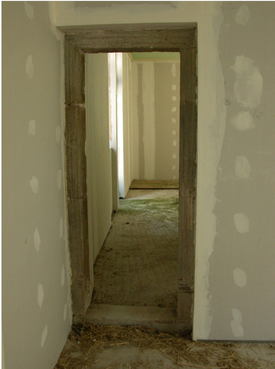
Vue intérieure du rez-de-chaussée surélevé : encadrement de porte.
