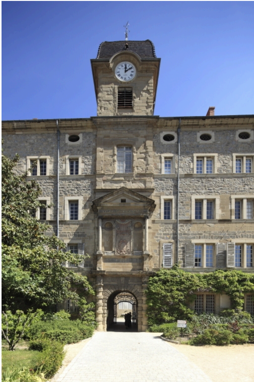
Bâtiment A. Façade occidentale, 16e et 18e s.
