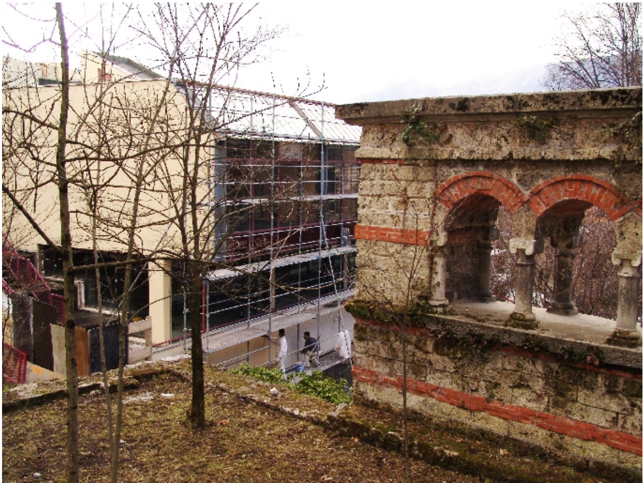
Détail du couronnement
