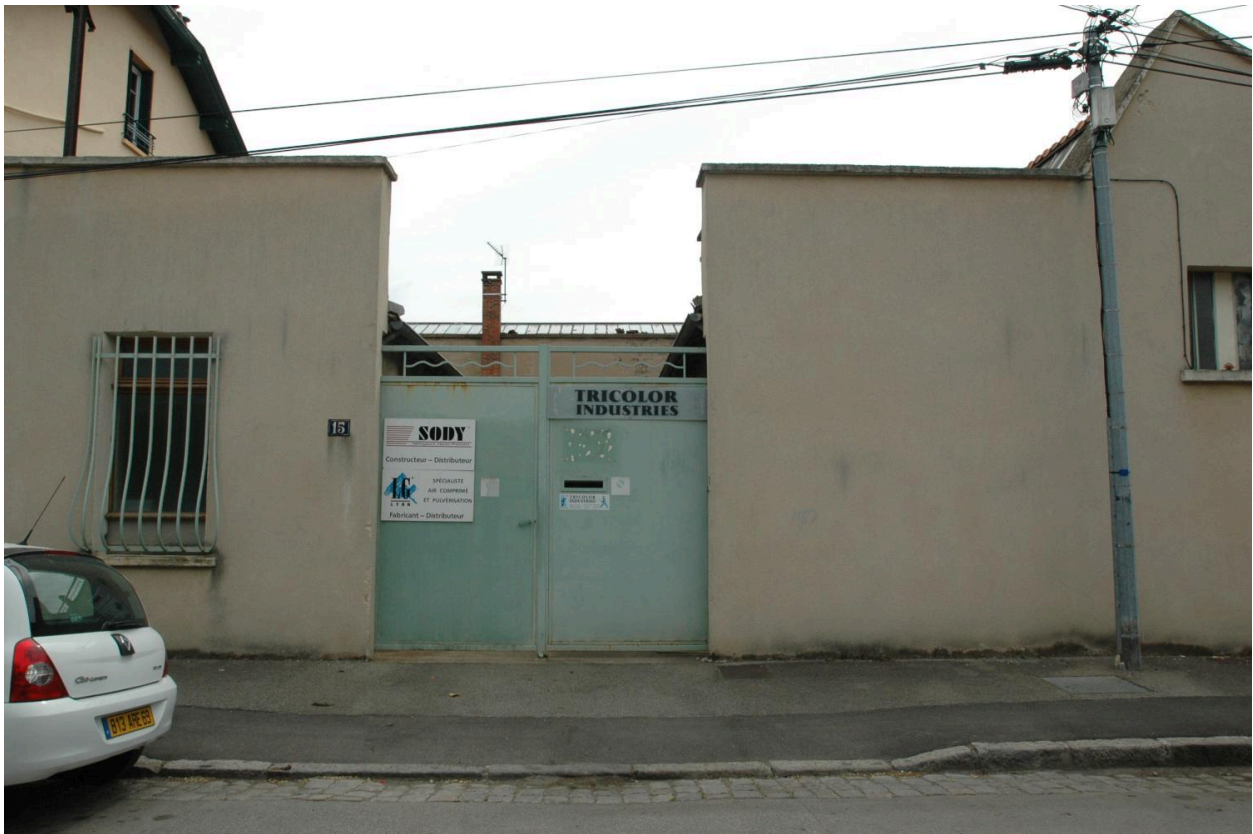
Détail entrée principale
