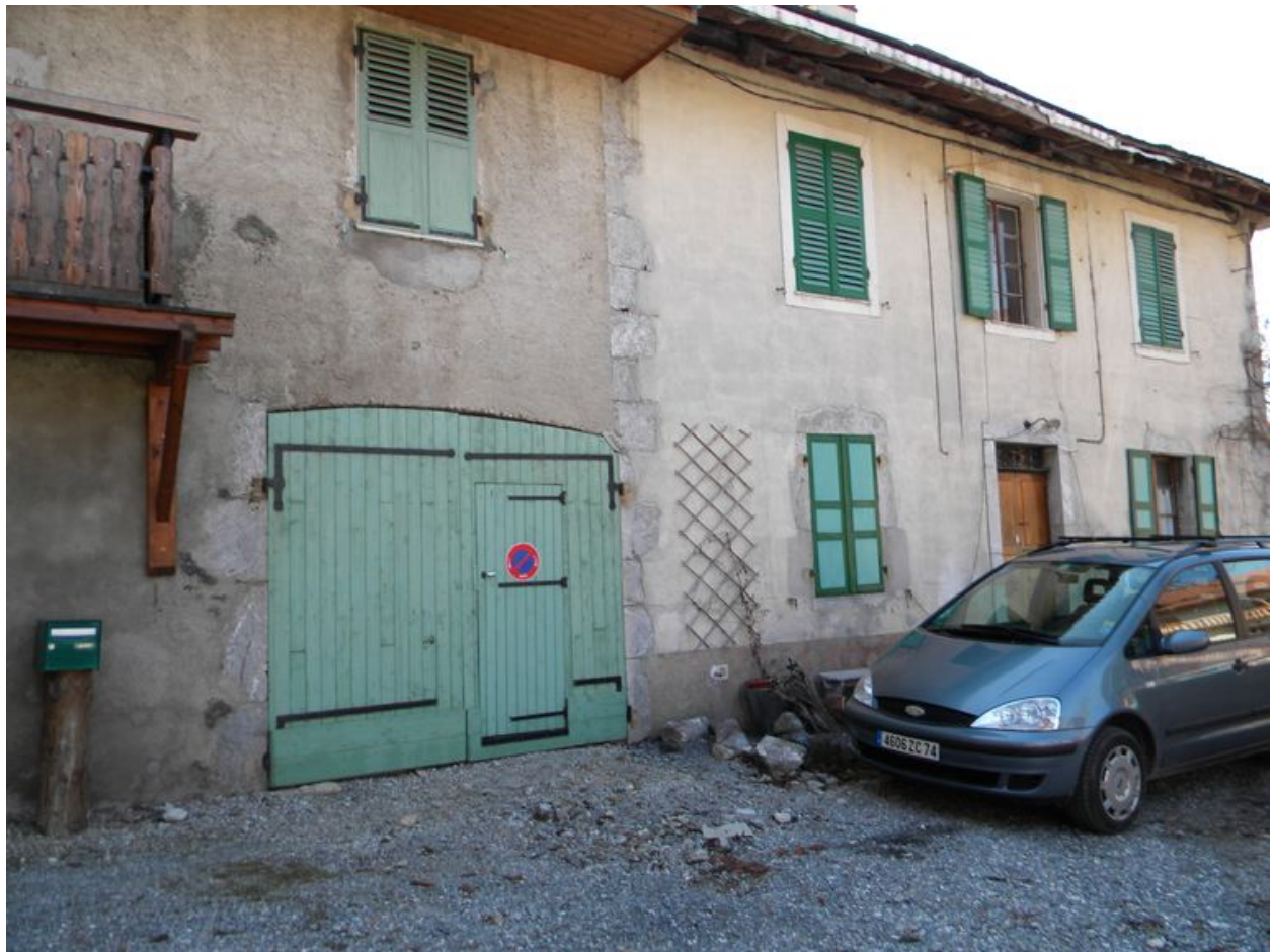
Vue de la façade principale, avec jonction entre la maison du meunier et les extensions agricoles.
