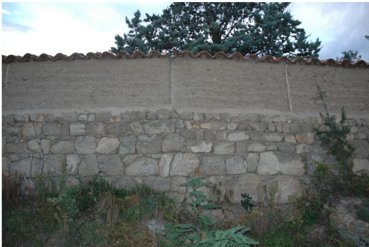
Mur de clos en pisé (Montbrison, Moingt, Sous Rigaud, AC 67a).
