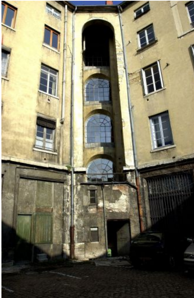
Vue de la travée d'escalier depuis la cour
