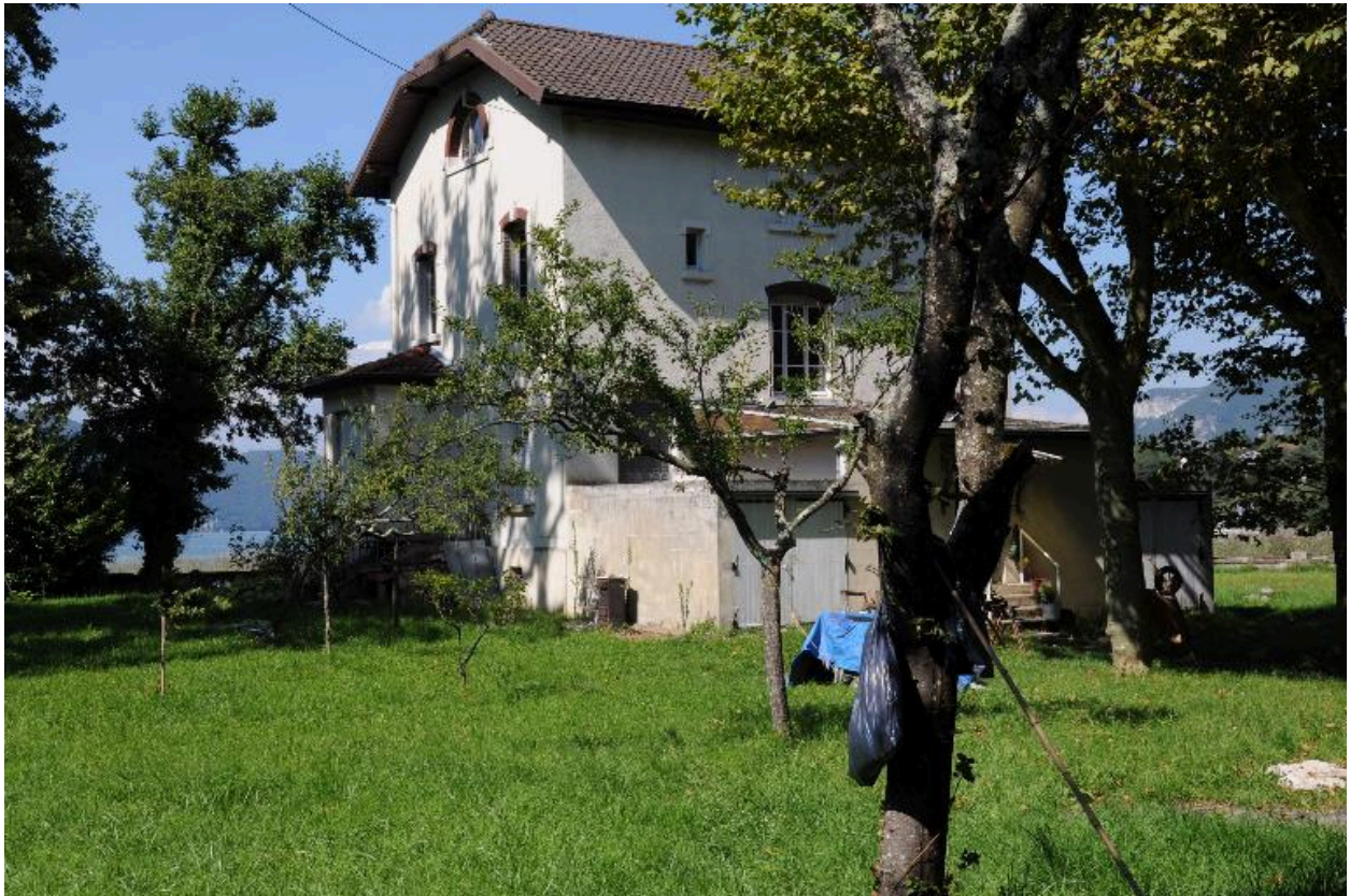
Vue d'ensemble : façade est et sud
