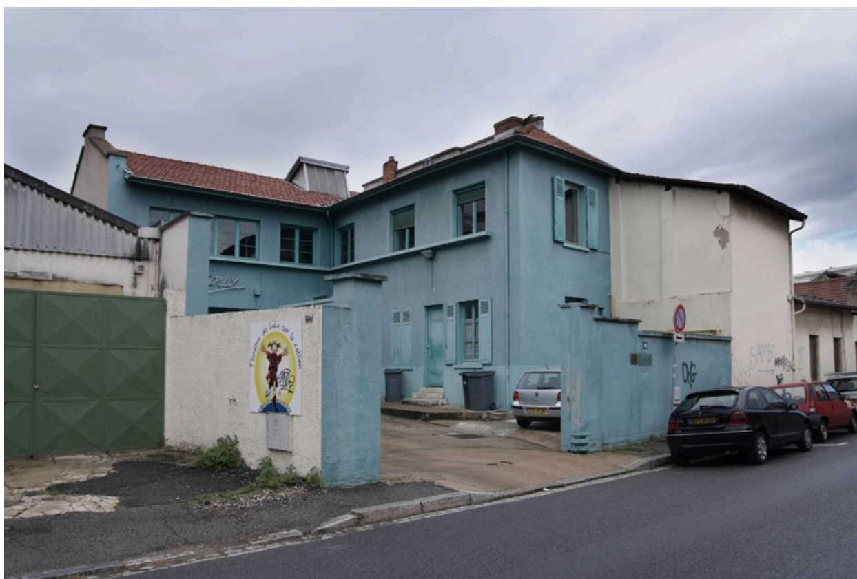
Vue générale nord-est, 58 rue Victor Lagrange
