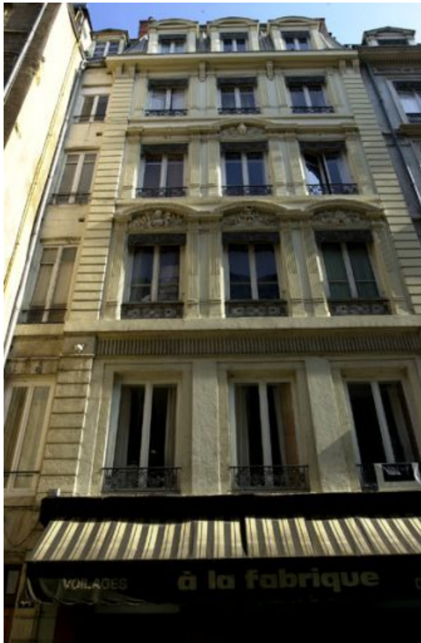
Façade rue Dubois, vue générale par-dessous
