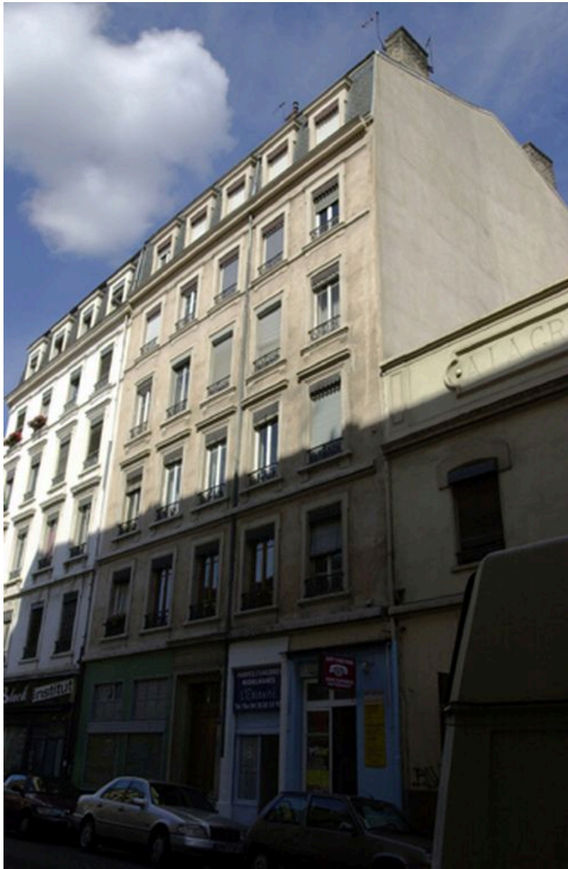
Elévation principale depuis le nord-est
