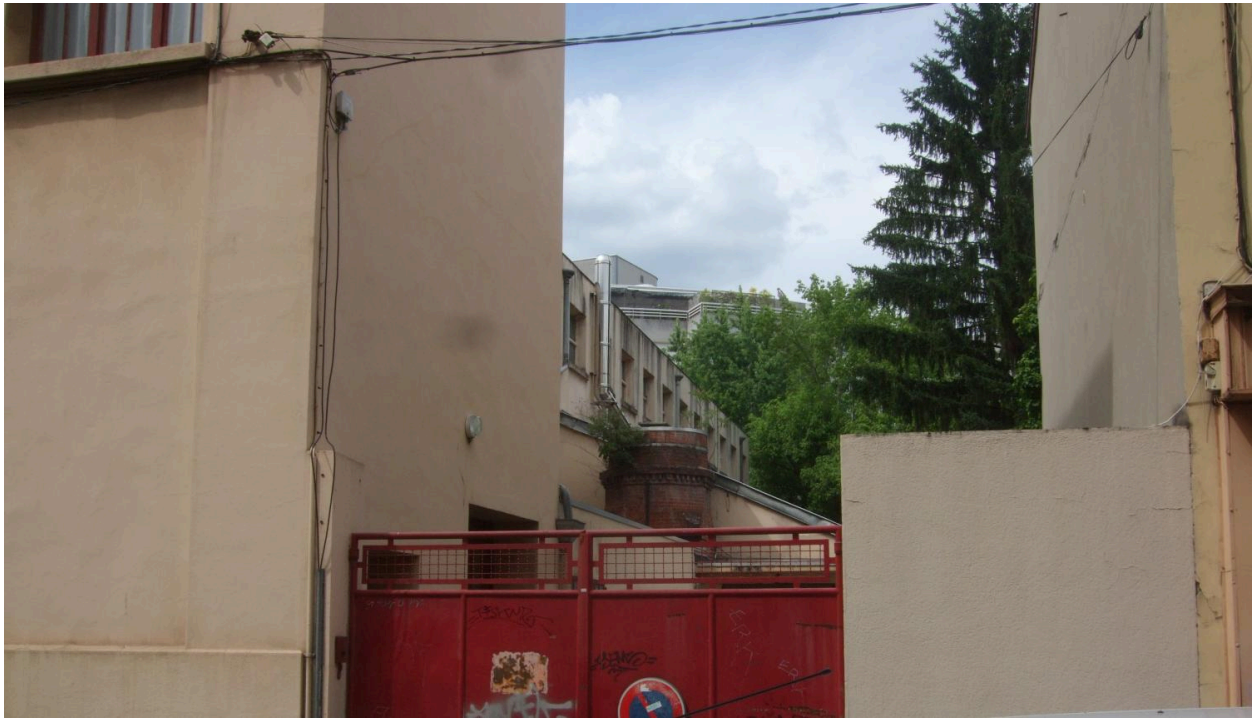
Vue de l'embase de la cheminée
