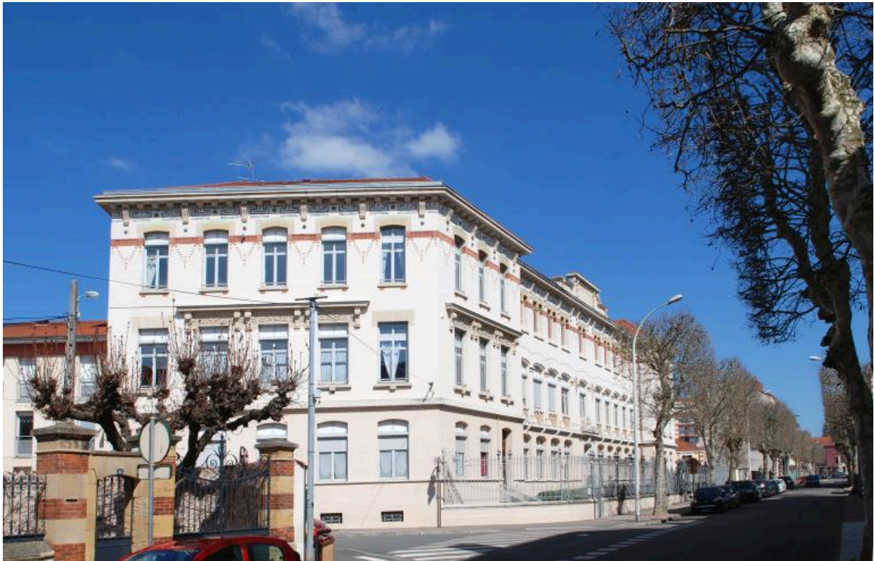
Elévation principale, depuis le sud
