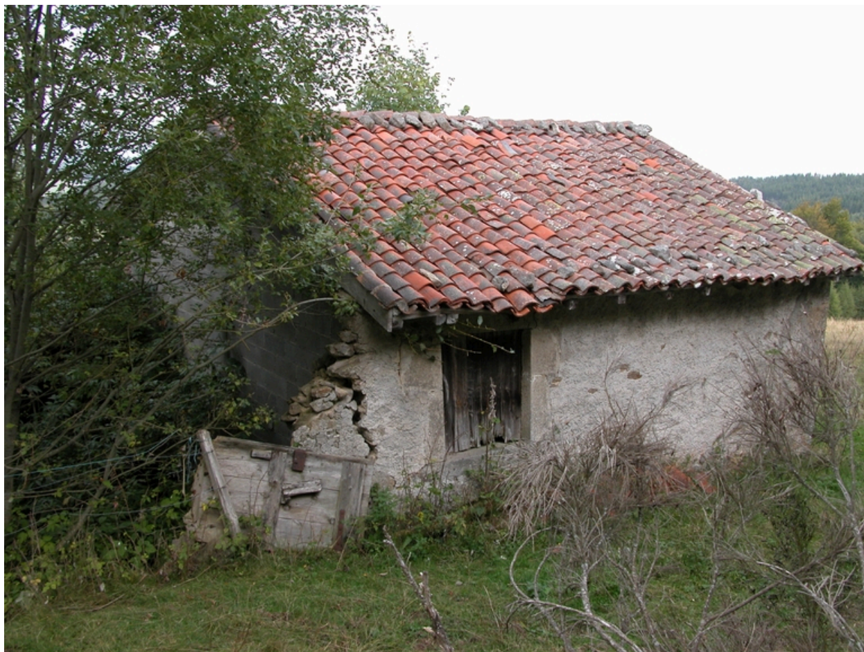
Vue arrière de la partie existante.
