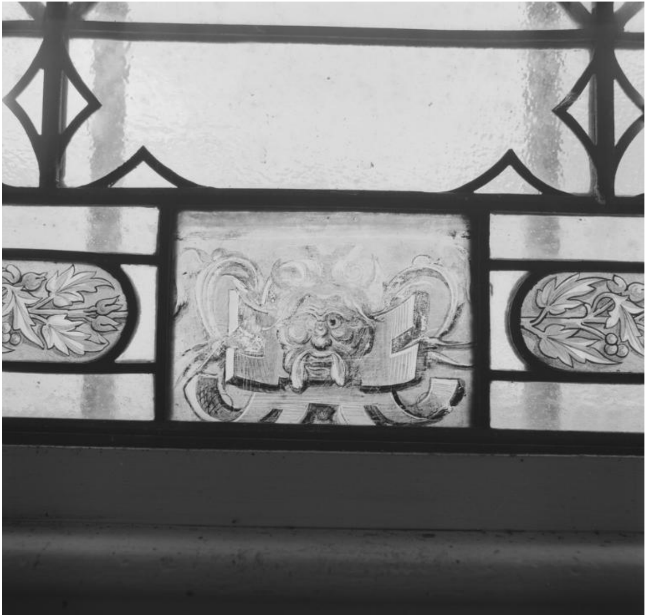
Détail de la baie 1 : partie basse.
