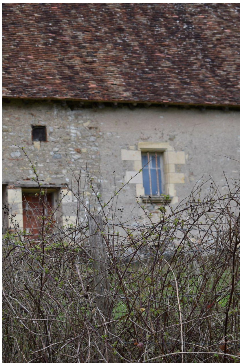
Façade occidentale : détail des baies.
