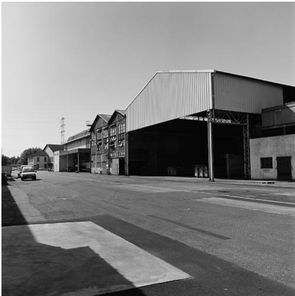
Fonderie, secteur noyautage.
