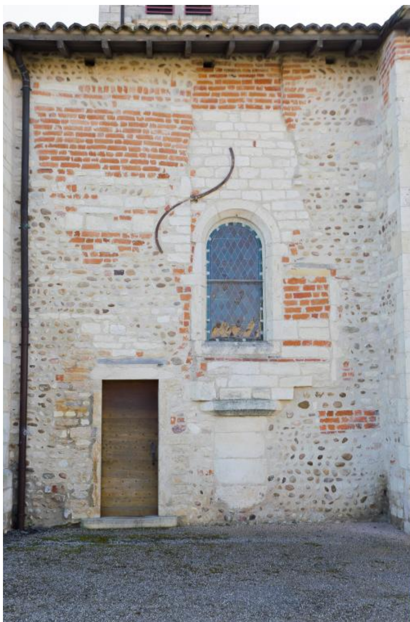
Élévation nord, espace de l'avant-chœur.
