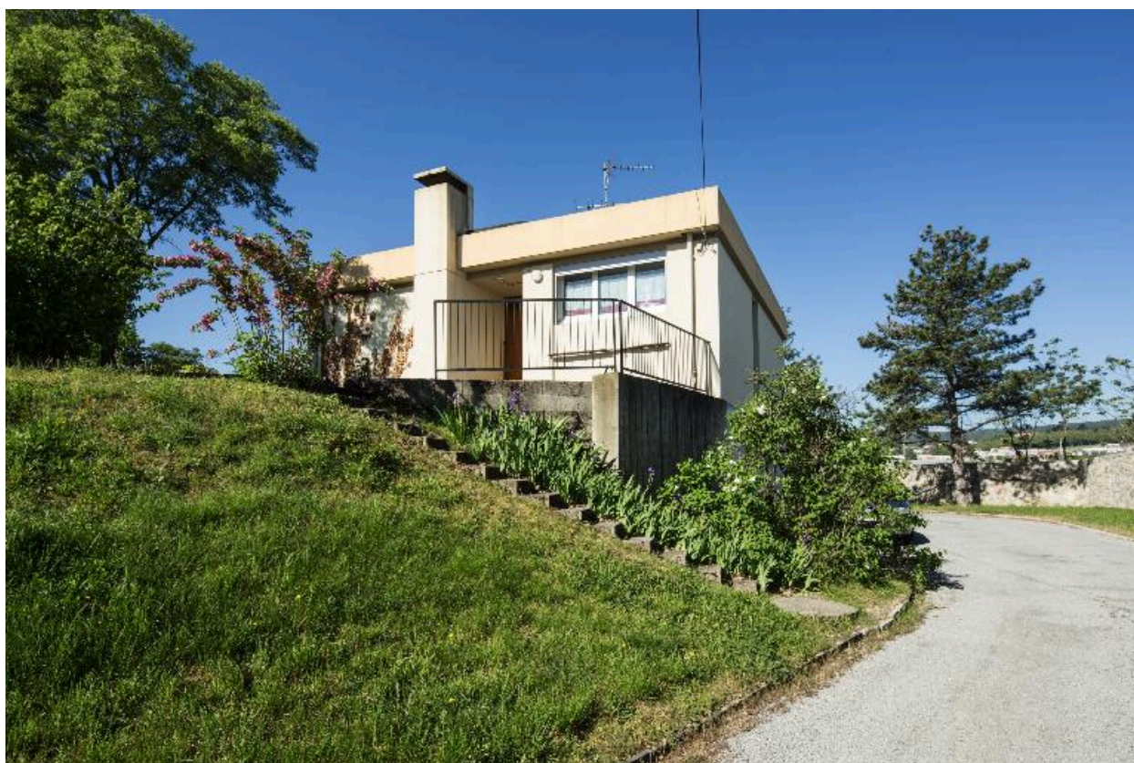
Maison de la directrice : vue extérieure, façades ouest et nord
