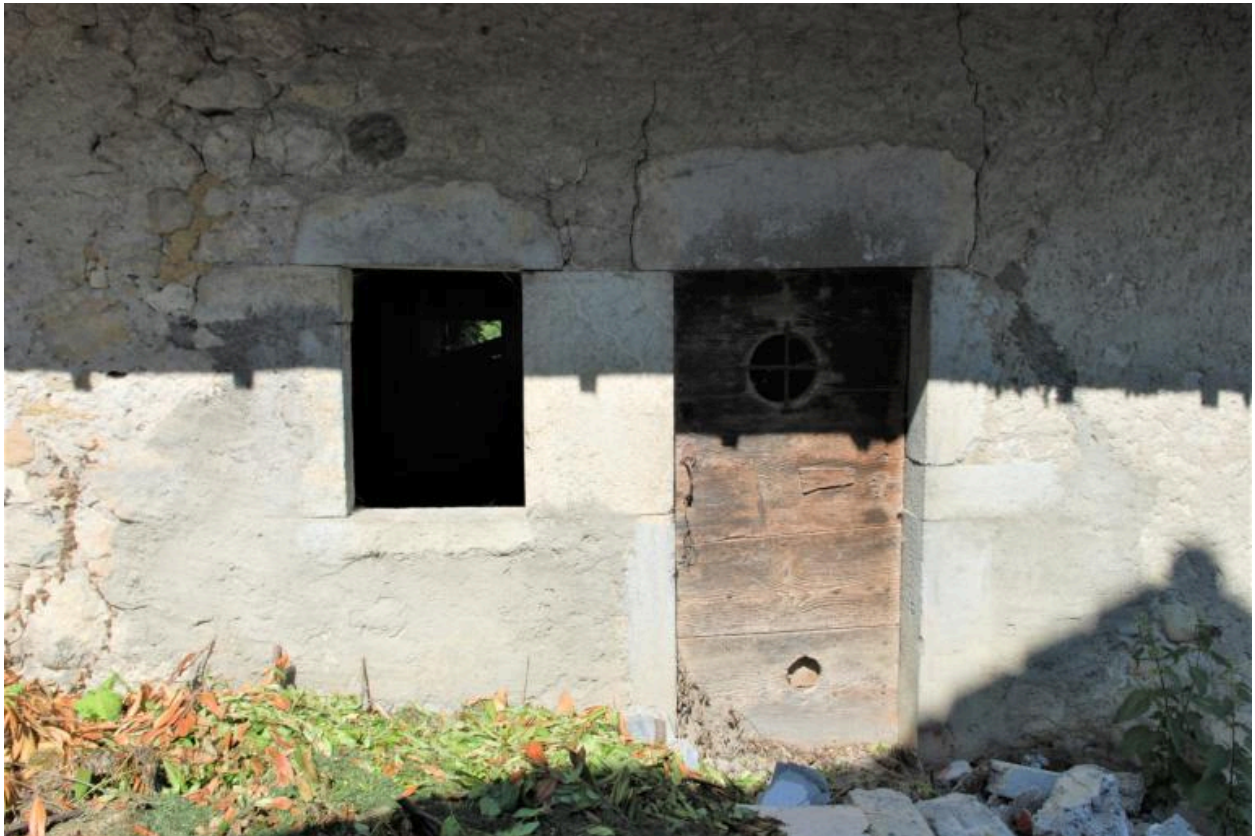
Détail des ouvertures de l'étable située en amont.
