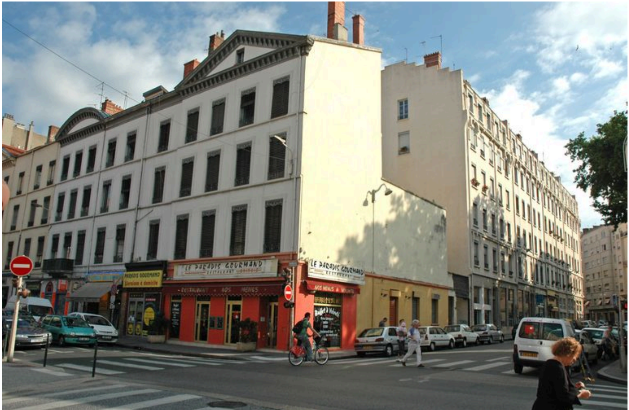
Vue d'ensemble depuis le sud-est, la rue de Créqui à l'est
