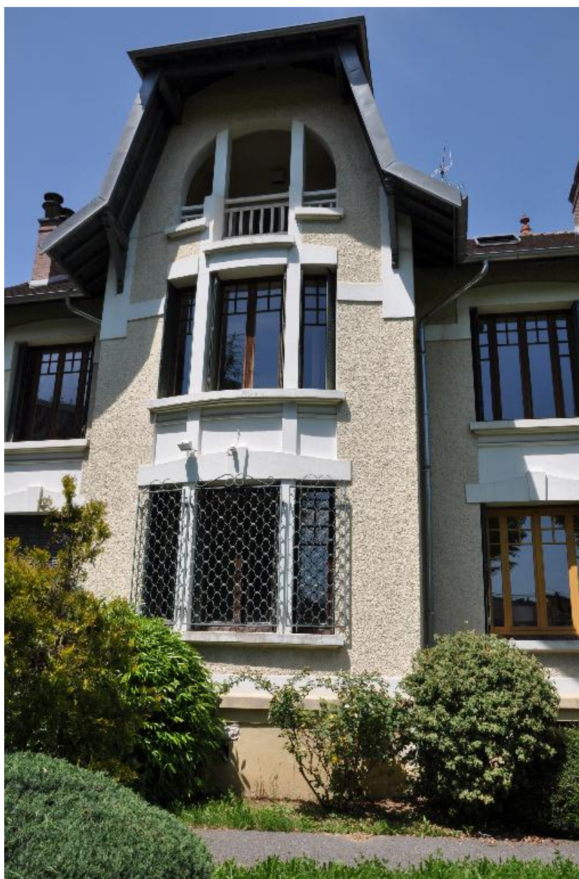
Détail de la travée centrale
