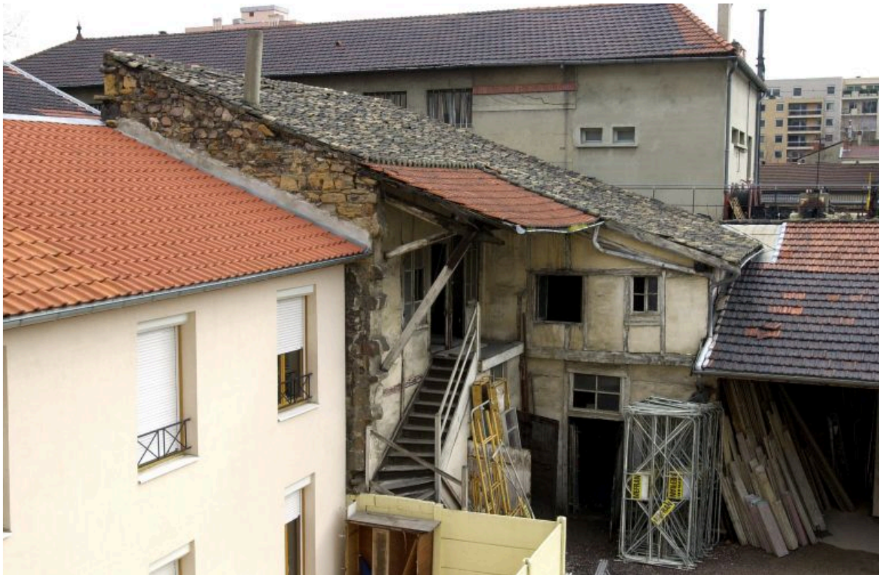
3 rue Denuzière. Maison de type rural construite en fond de cour, derrière un immeuble
