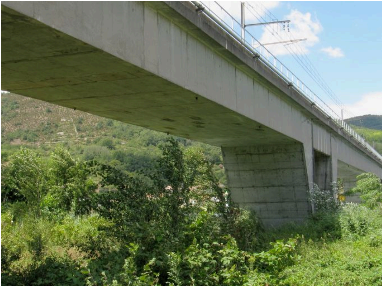
Vue partielle, de dessous, tablier et pile (depuis la rive gauche)
