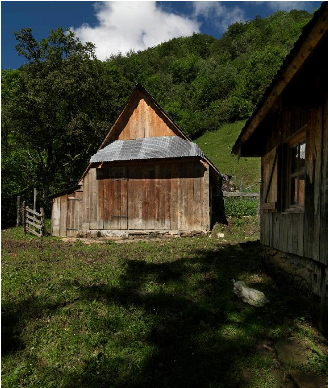
Vue depuis le sud-ouest.
