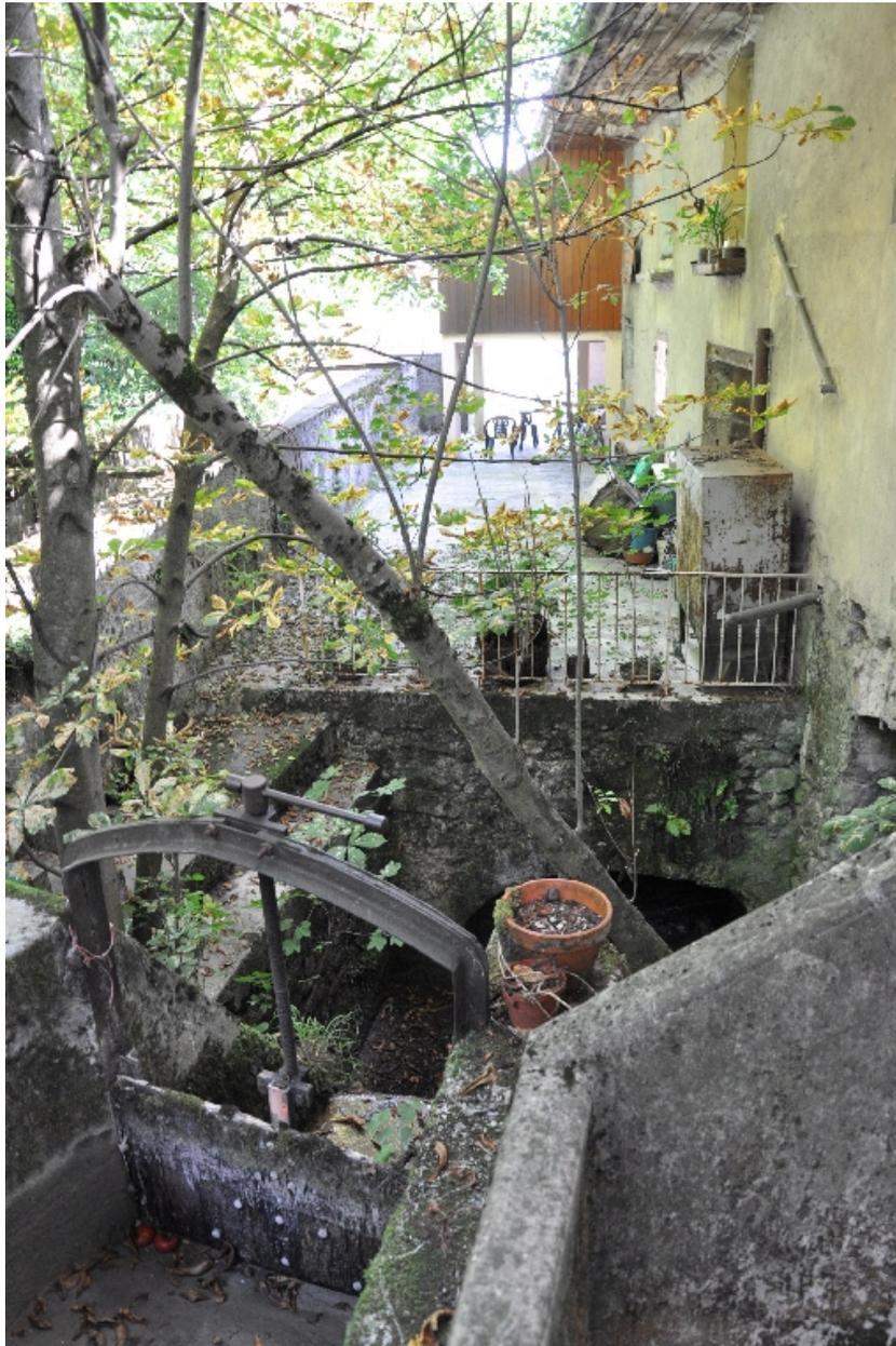
Ouvrages en maçonnerie de prise d'eau et de dérivation
