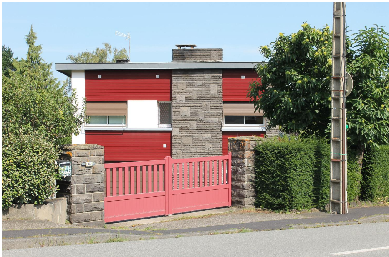
Ceyrat, la maison A.* vue de l'ouest.
