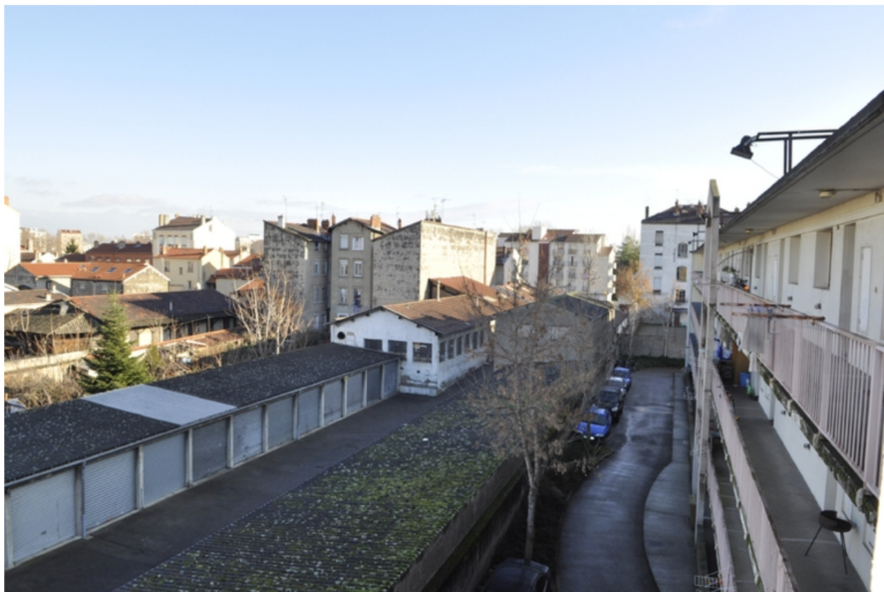
Vue d'ensemble ouest du site
