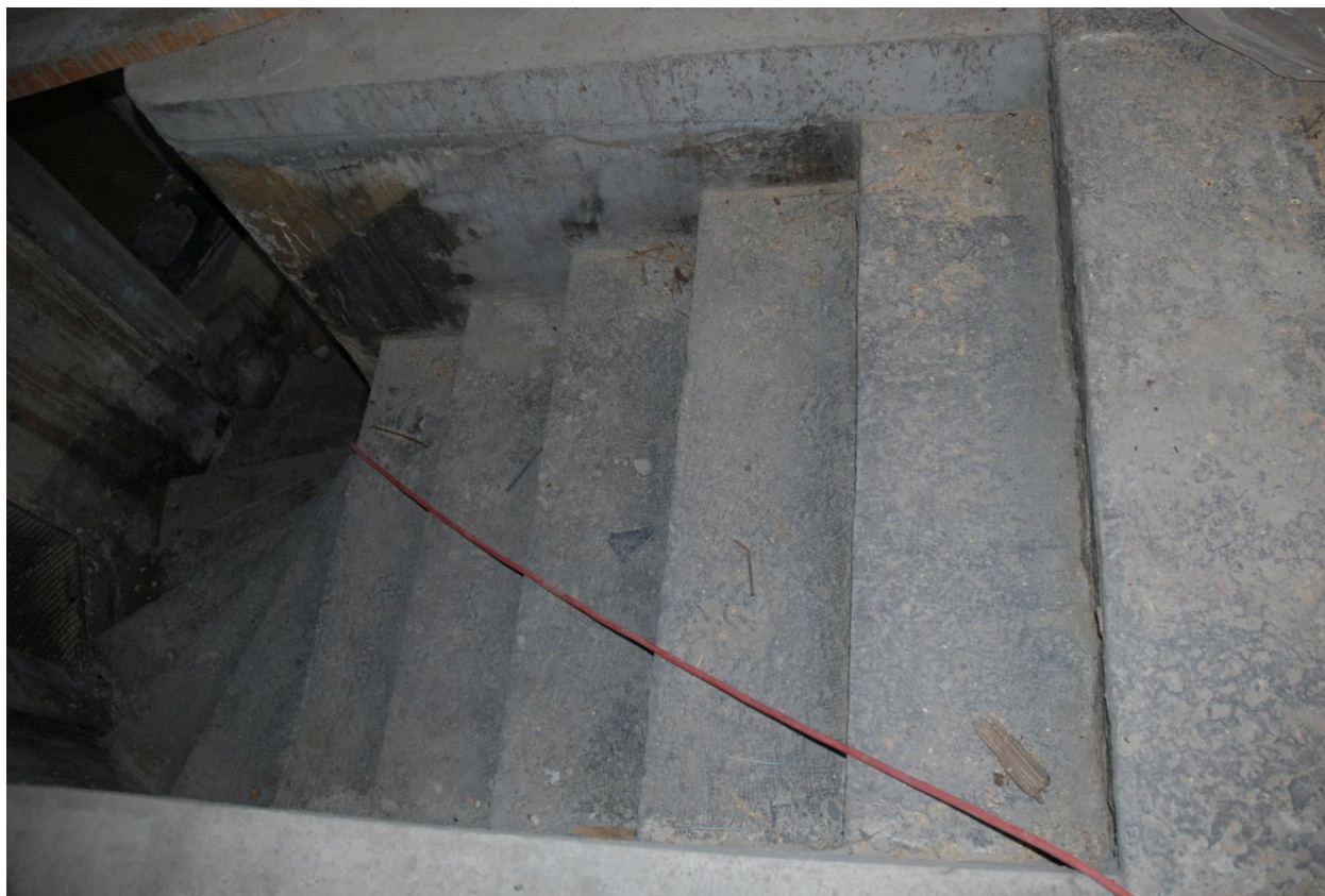
Vue intérieure de l'escalier : volée aboutissant au 3e étage.
