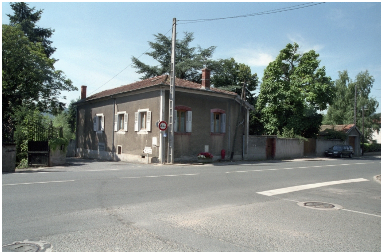
Boën, îlot 14, RN 89, 19. Vue générale de la façade sur rue.
