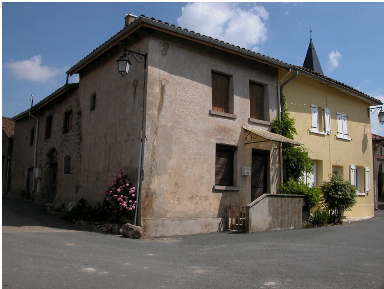
Vue générale depuis le sud-ouest (parcelles 1984 E1 et E 2).
