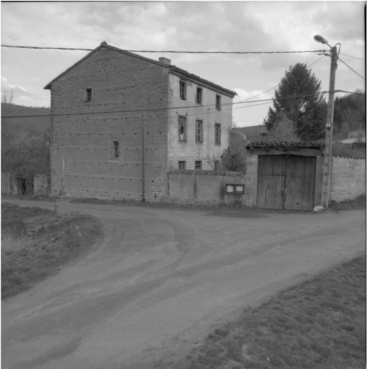
Débats-Rivières-d'Orpra, le Martel (1987 A2 1048), type A1. Vue d'ensemble de la ferme depuis la route.
