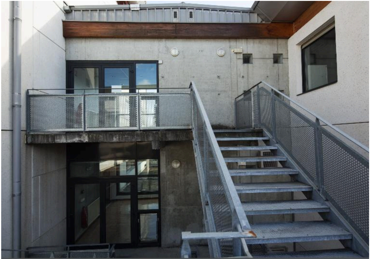
Bâtiment E. Escalier
