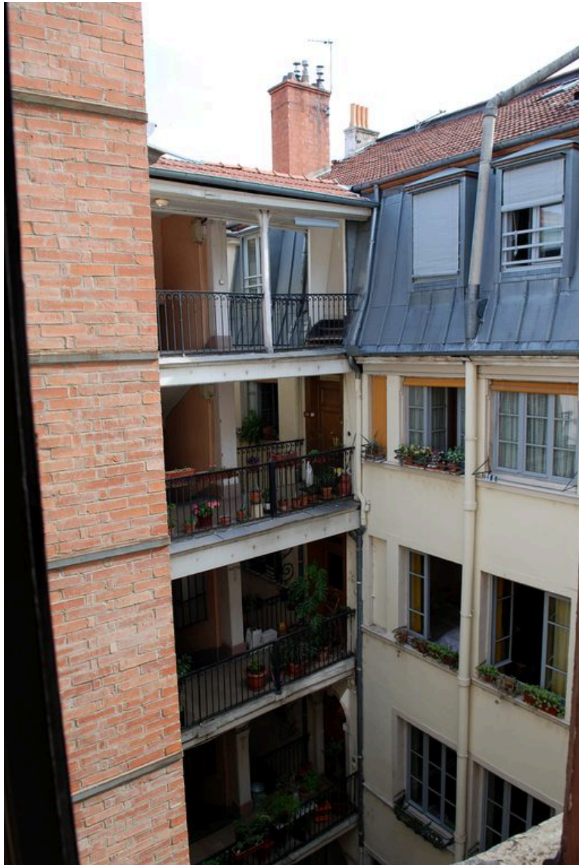
Vue partielle du corps de bâtiment est et de la cage d'escalier depuis l'immeuble sis 1 place des Jacobins
