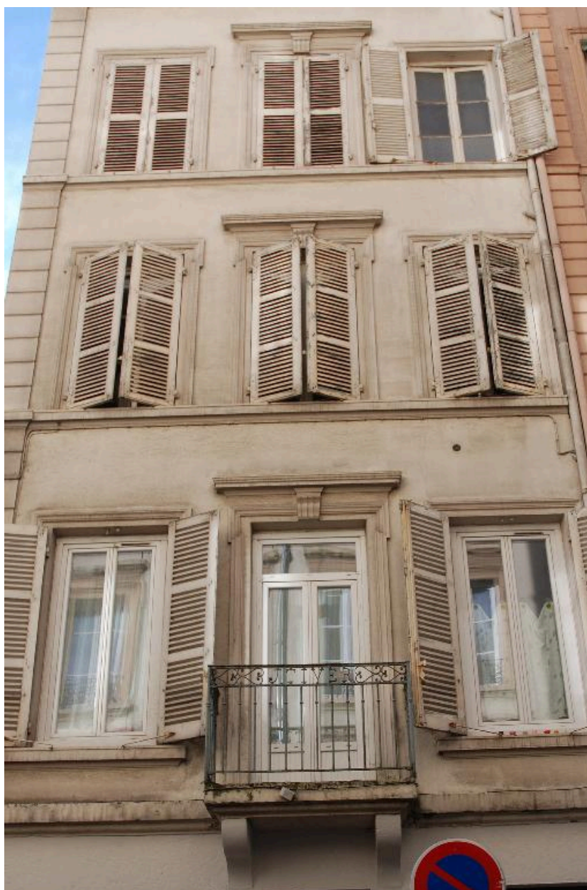
Vue rapprochée de l'élévation sur rue
