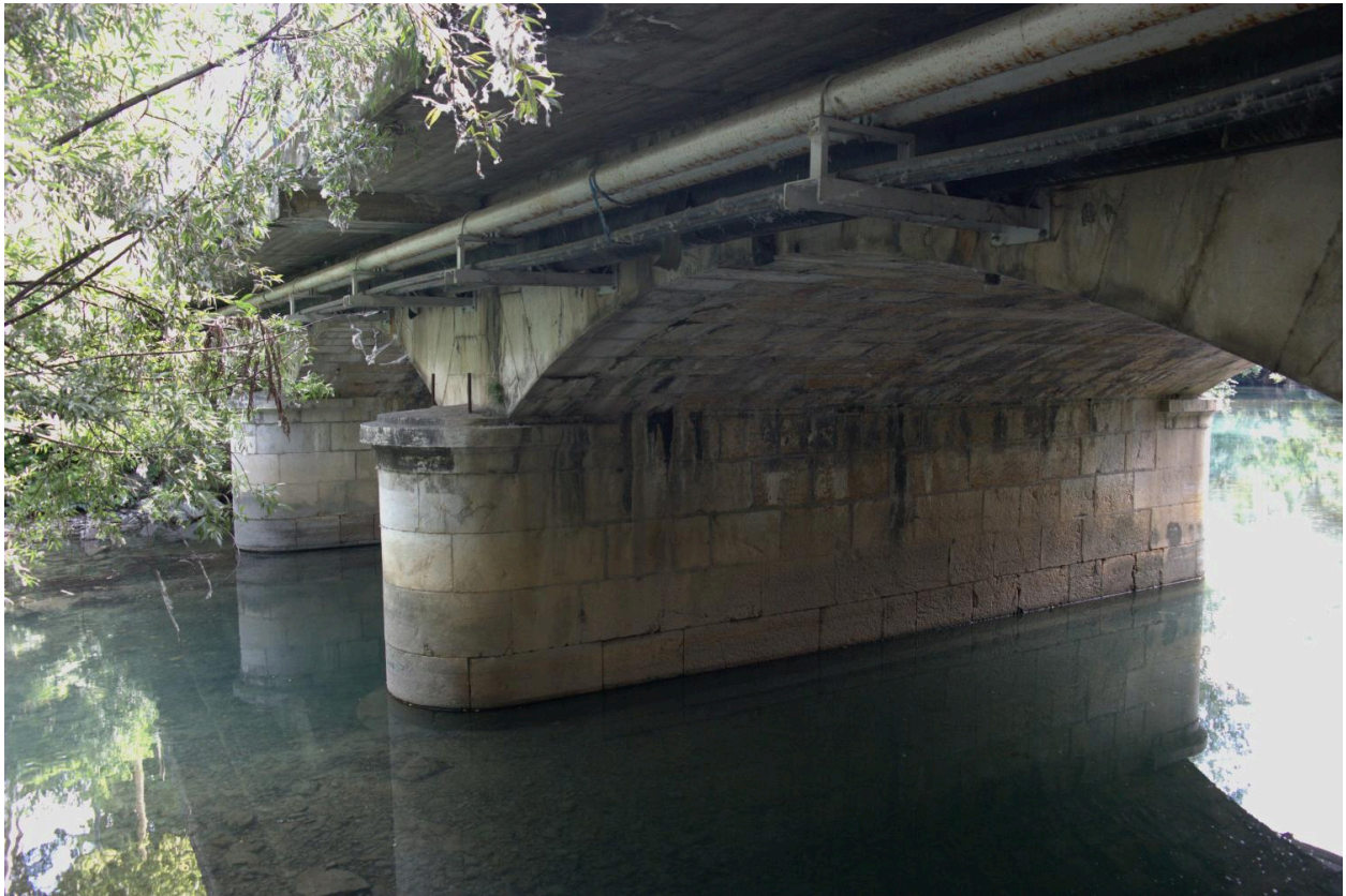
Pont Neuf, détail de l'élargissement et d'une pile
